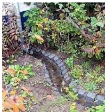
hemelwater oppervlakkig afvoeren
